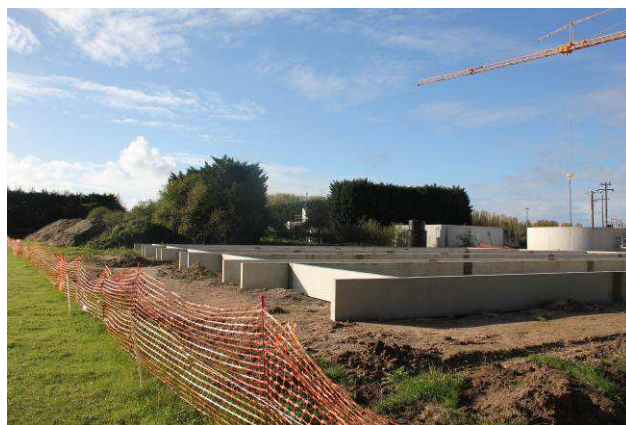
Aménagement de la nouvelle station d'épuration en 2012
